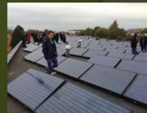
Hillerød: PV op dak CC, werking 100 % CO2-neutraal
